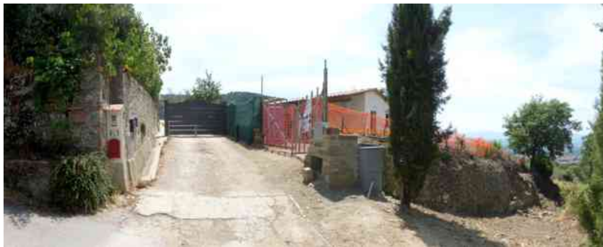
d – ingresso al complesso immobiliare
