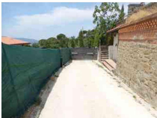
e – strada interna al complesso in prossimità dell'ingresso
